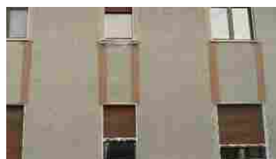
Appartamenti Casalpusterlengo Vittadone - Via Piave
